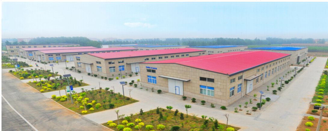
工程训练中心
